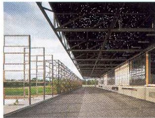
Werkerweiterung Fensterfabrik Baumgartner AG, Hagendorn-Cham, Schweiz; Entwurfsverfasser: Niklaus Graber, Christoph Steiger, Stefan Koepfli, (Koepfli Partner GmbH)
