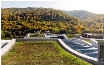
Der ZinCo Systemaufbau mit Floradrain® FD 40 sorgt dafür, dass sich die Grassoden der „Armenische Wiese“ gut verwurzeln und weiterwachsen. © Danil Kolodin / Tim Flynn architects
