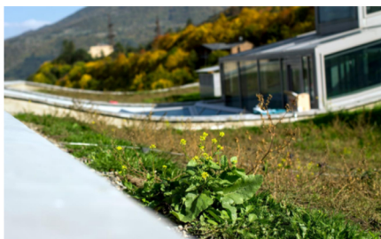
Die enorme Pflanzenvielfalt der 1 m breiten Streifen Grassoden am Dachrand wird sich mit der Zeit auch auf das Innere der Dachflächen ausbreiten. © Danil Kolodin / Tim Flynn architects
