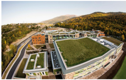
Rund 7.000 m 2 Gründachfläche sorgen dafür, dass sich die Gebäude in die Umgebung des Nationalparkwaldes einfügen. Ein Bauprojekt mit vielfacher internationaler Auszeichnung. © Danil Kolodin / Tim Flynn architects
