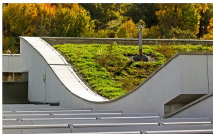
In Profil ist die Dachneigung mit bis zu 10° sehr gut zu erkennen. © Danil Kolodin / Tim Flynn architects
