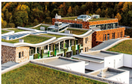
Die Aufteilung in mehrere kleine Dachflächen wirkt aufgelockert. Mit jährlich neuen Pflanzensammelaktionen soll der Artenreichtum gezielt erweitert werden. © Danil Kolodin / Tim Flynn architects
