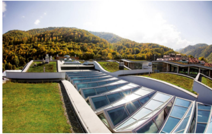
Spielerisches Auf und Ab: die grünen Wellen wechseln sich ab mit einem zickzackförmigen Glasdach. © Danil Kolodin / Tim Flynn architects
